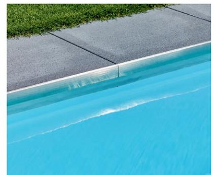
Die Poolumrandung besteht aus einem mehrfach gekanteten Edelstahlblech. Um das Poolwasser vor Verunreinigungen zu schützen, schiebt sich das Blech 15 Zentimeter unter den Plattenbelag um den Pool herum.
